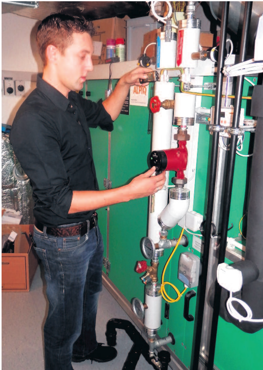
André Hug von Balzer Ingenieure in Chur prüft die Funktion eines Luftheriteranschlusses.
